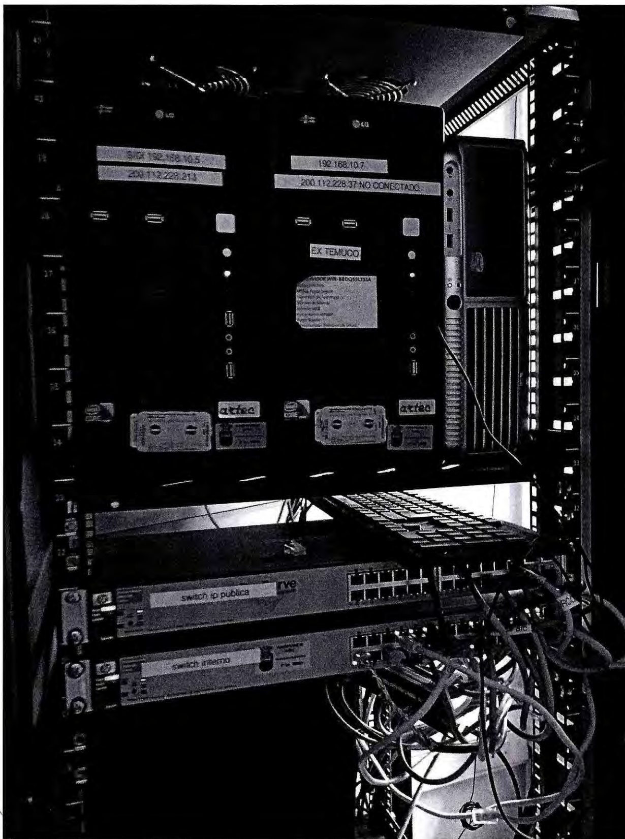
Fotografía N° 5 Switch y Routers
