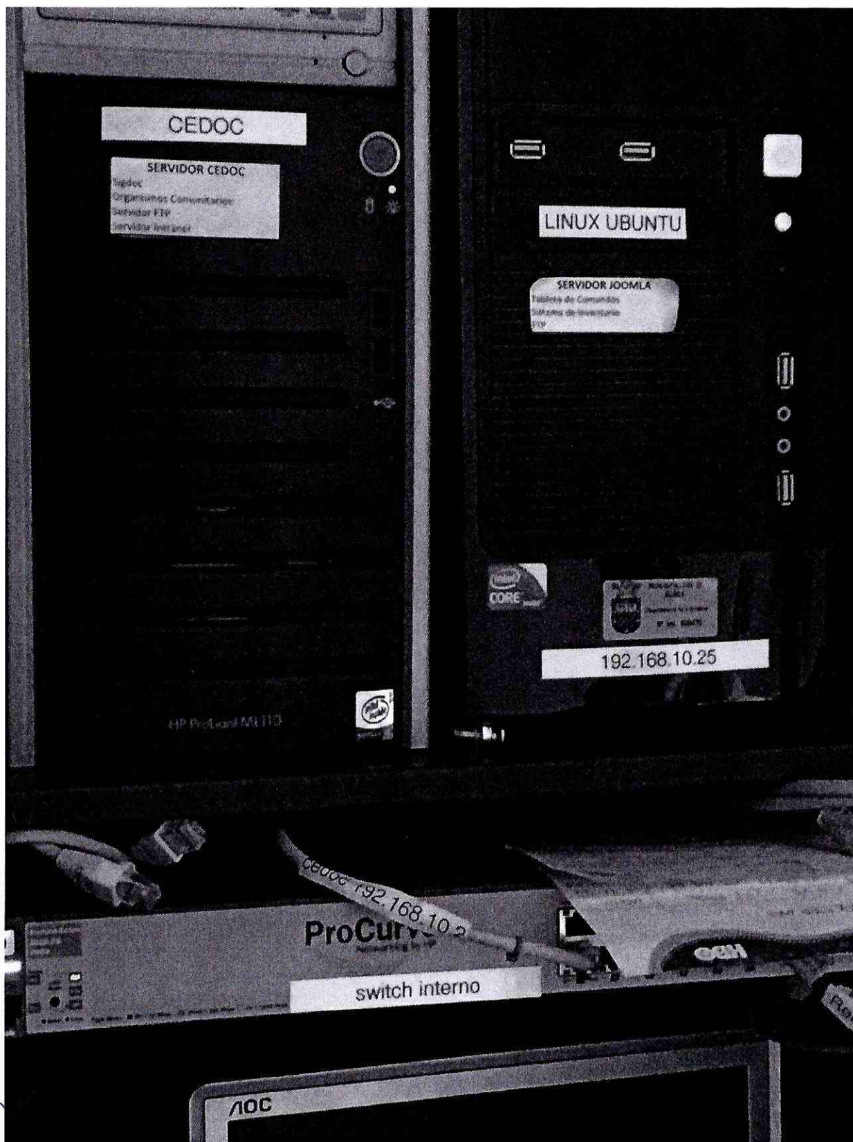
Fotografía N° 4 Gabinete de servidores.
