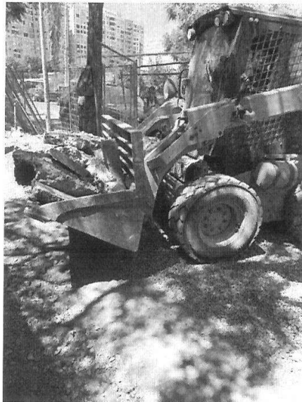
Calle Las Encinas - maquinaria retirando escombros de demolición - febrero 2026
